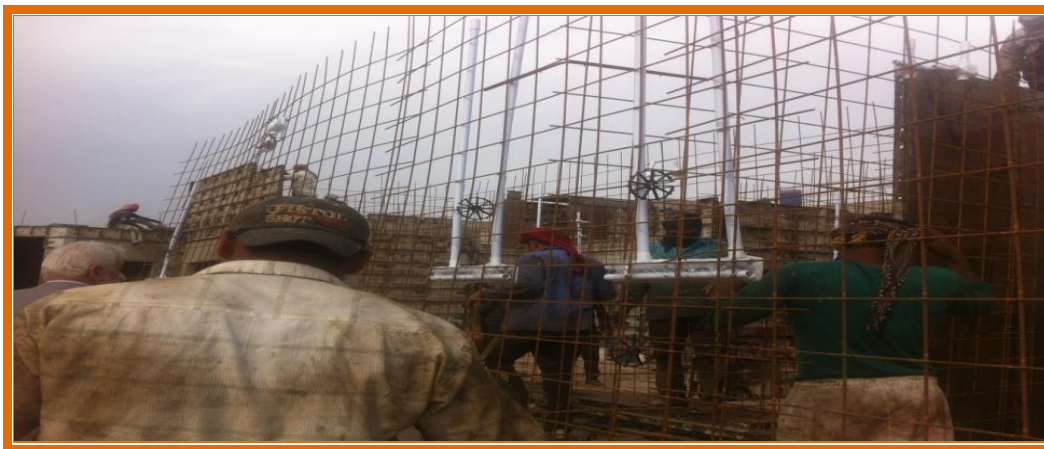
شكل (14) طريقة تسليح الدار المصدر/فريق الدراسة(الباحثين) زيارة ميدانية للمشروع،2014.
