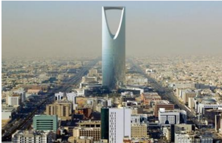
الشكل(4) مركز برج الرياض
