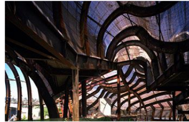
الشكل رقم (2) هياكل انشائية في تجربة مشروع موسيقي في سياتل لفرانك كيري انتج باستخدام القطع Cutting باستراتيجية الكنتور Contouring (Kolarevic,2001, pp.120-122)
