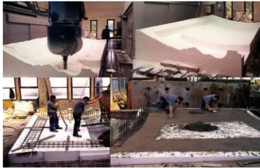
الشكل رقم (3) طحن قوالب البوليميرين الرغوي لصب ألواح الخرسانة المسلحة لأبراج زولهوف التي صممها جيري في دوسلدورف، ألمانيا 1999 (Kolarevic,2001, pp.120-122)
