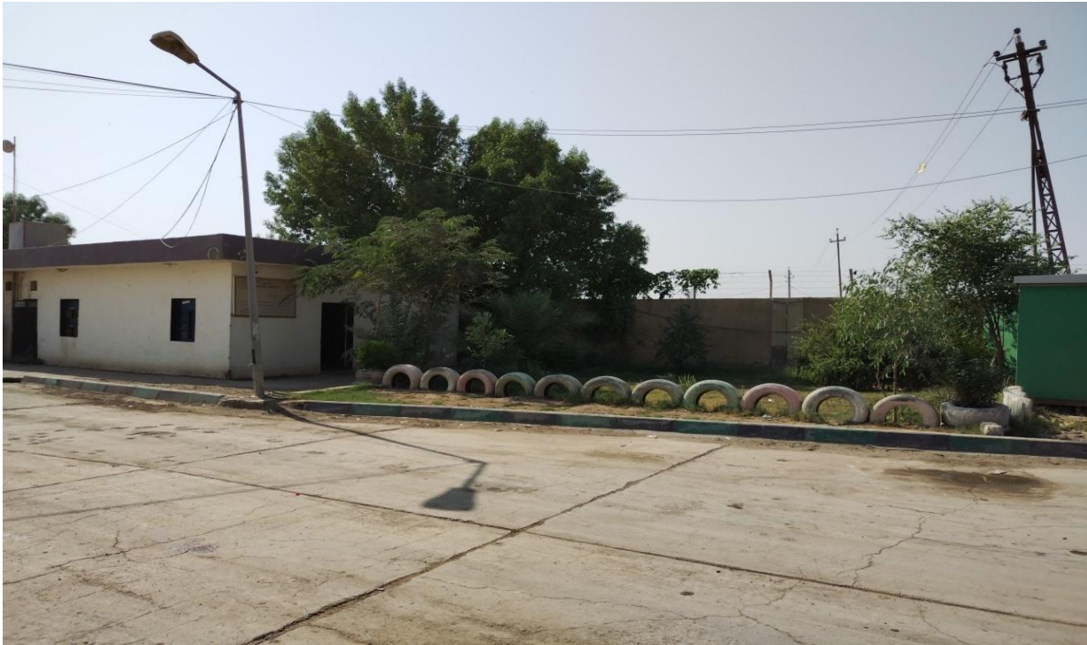
شكل (١٢، أ) يوضح تبليط ارضية المحطة بالخرسانة الصقالية وباستعمال الاسمنت المقاوم للأملاح المصدر : الباحثين الدراسة الميدانية ، ٢٠٢٢
