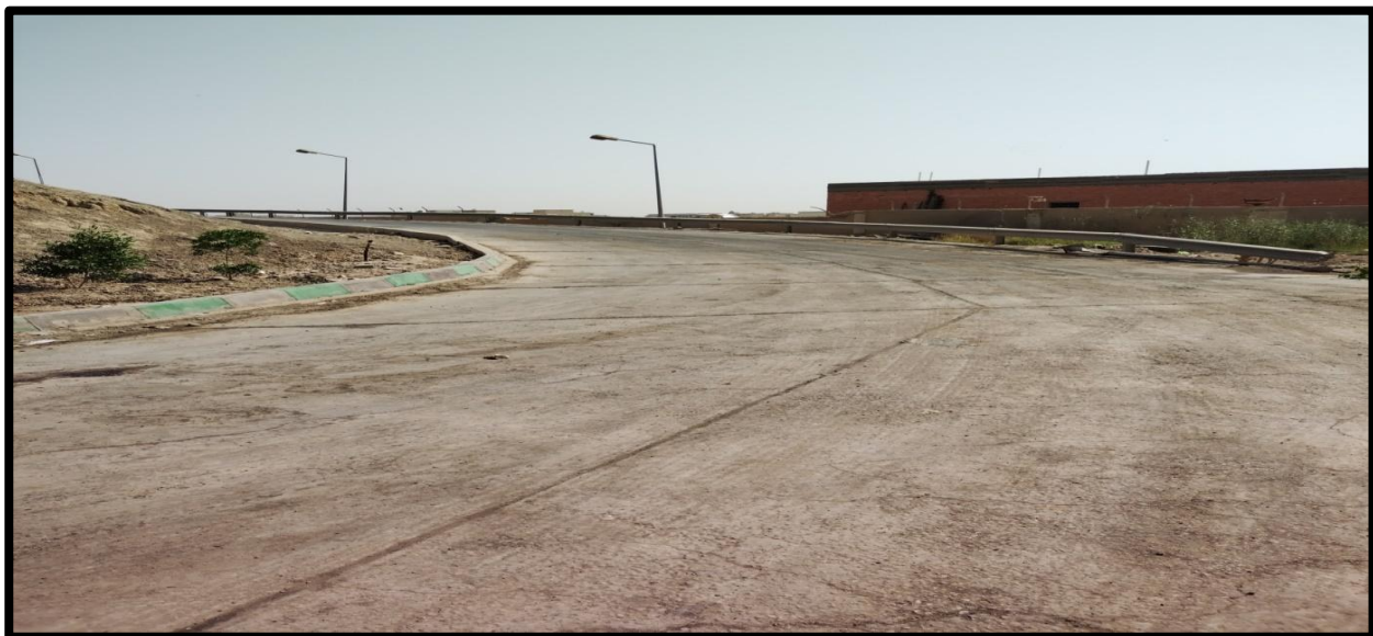
شكل (١٢، ب) تبليط ارضية المحطة بالخرسانة الصقالية وباستعمال الاسمنت المقاوم للأملاح المصدر : الباحثين الدراسة الميدانية ، ٢٠٢٢
