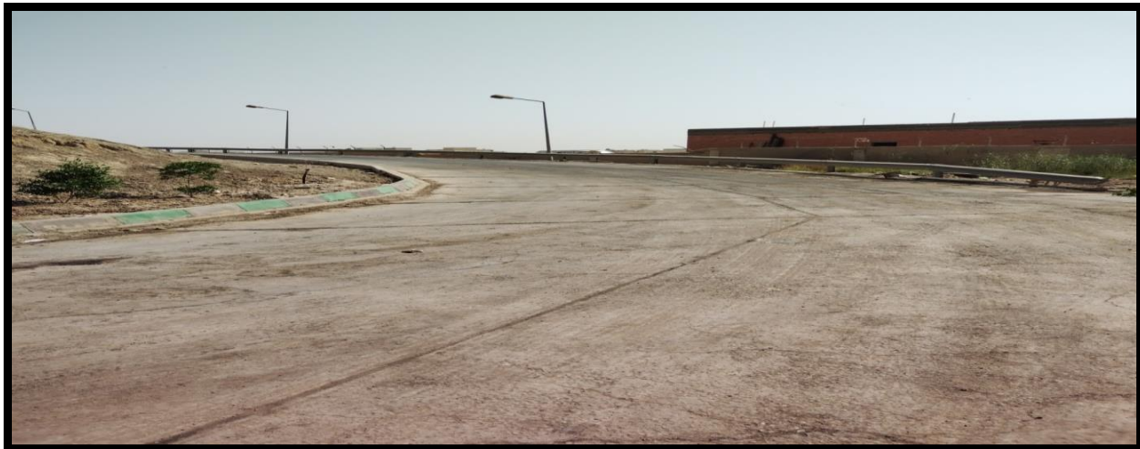
شكل (١٢، ب) تبليط ارضية المحطة بالخرسانة الصقلية وباستعمال الاسمنت المقاوم للأملاح المصدر : الباحثين الدراسة الميدانية ، ٢٠٢٢
