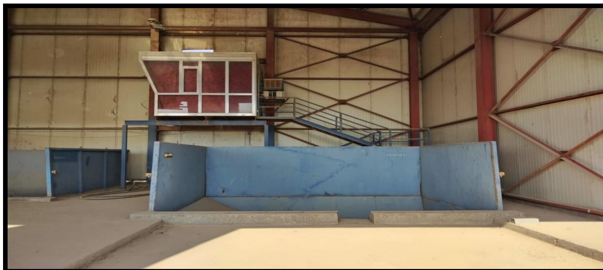
شكل (١٥) نظافة (الهوبر) الثانوي (الصغير) للمحطة التحويلية (المكبس) المصدر : الباحثين الدراسة الميدانية، ٢٠٢٢
