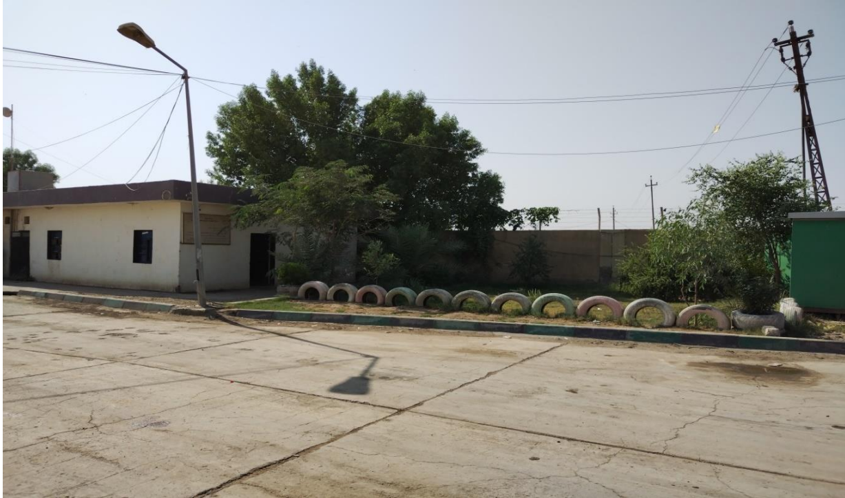
شكل (١٢، أ) يوضح تبليط ارضية المحطة بالخرسانة الصقلية وباستعمال الاسمنت المقاوم للأملاح المصدر : الباحثين الدراسة الميدانية ، ٢٠٢٢
