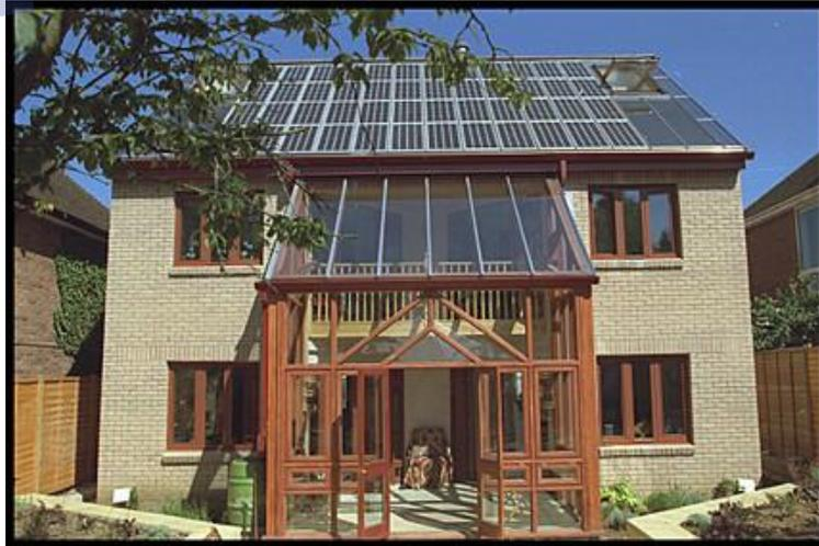
شكل (1-6) تغطية سطح المنزل بالخلايا الشمسية لتوليد الطاقة الكهربائية التي يحتاجها (جرين سبيس\_ 1995).
